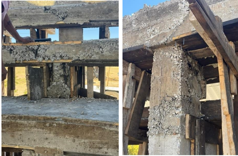
Evidencia de visita de obra.
