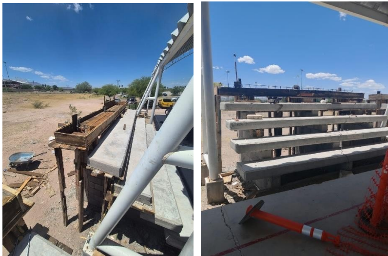
Evidencia de visita de obra.
