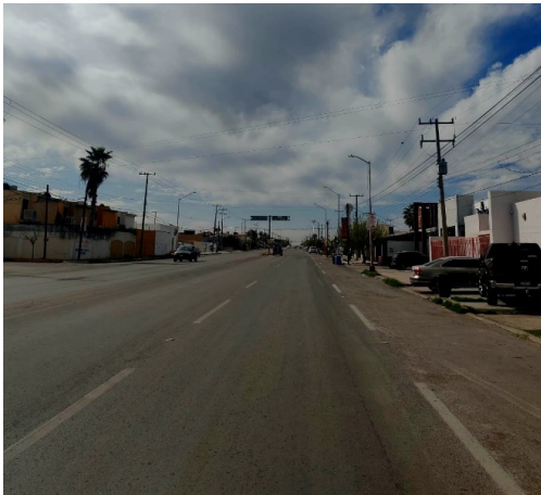
Suministro y Aplicación de Pintura Vial en Av. Río San Pedro
